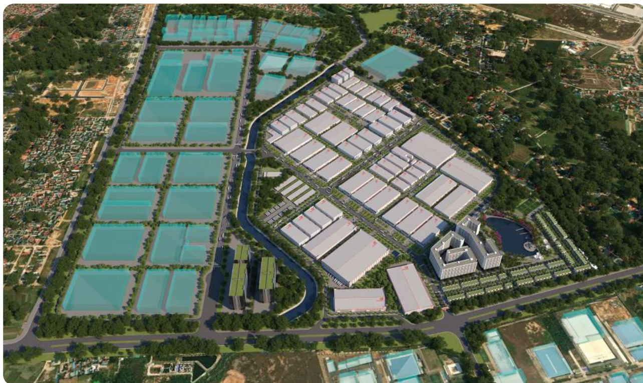
Dự án CNCTech Glory (KCN Bá Thiện 1, Vĩnh Phúc, nay là tỉnh Phú Thọ) CNCTech Glory Project (Ba Thien 1 Industrial Park, Vinh Phuc, now Phu Tho Province)
