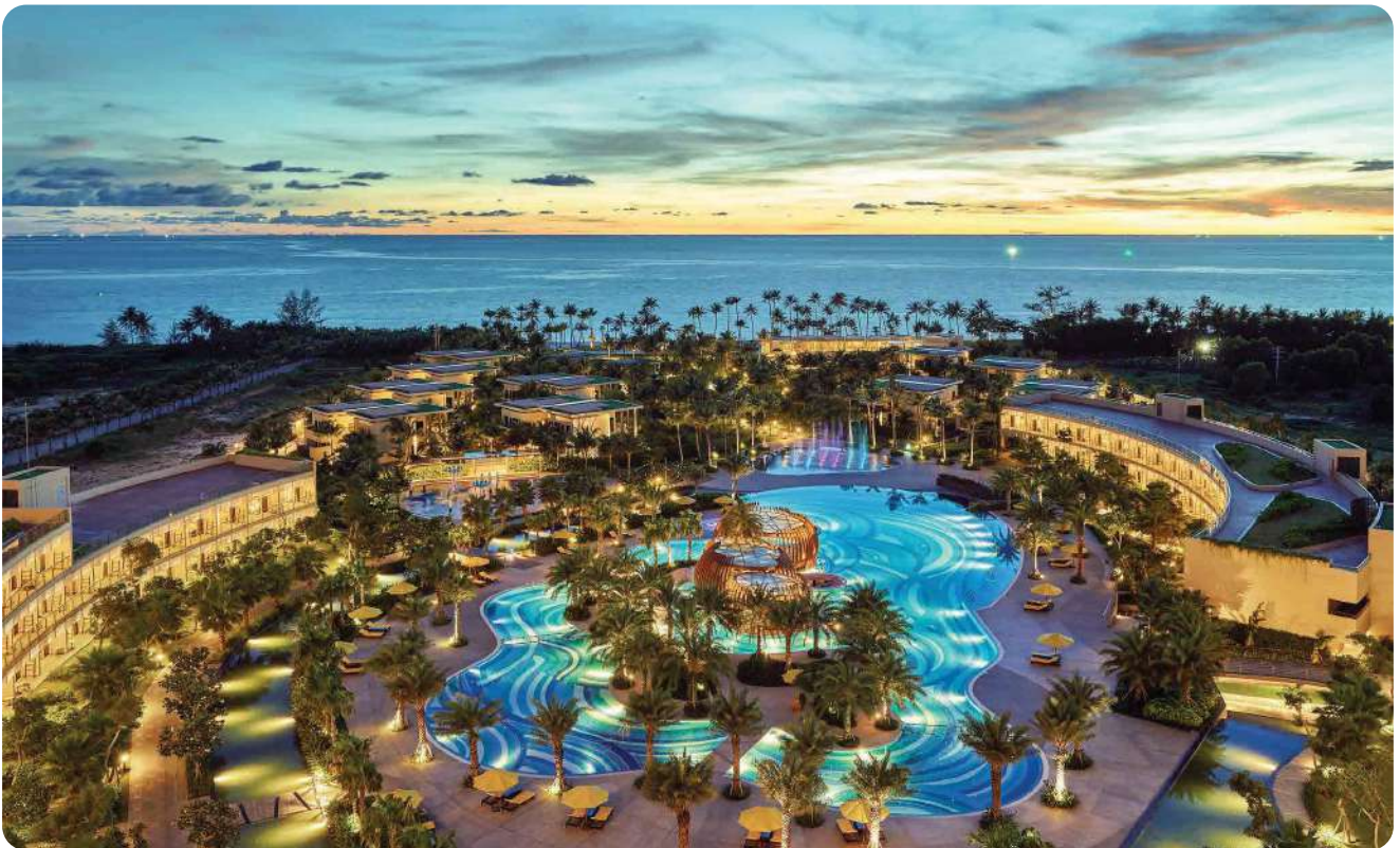
Dự án bể bơi vô cực Pullman Phú Quốc Infinity pool at Pullman Hotel Phu Quoc
