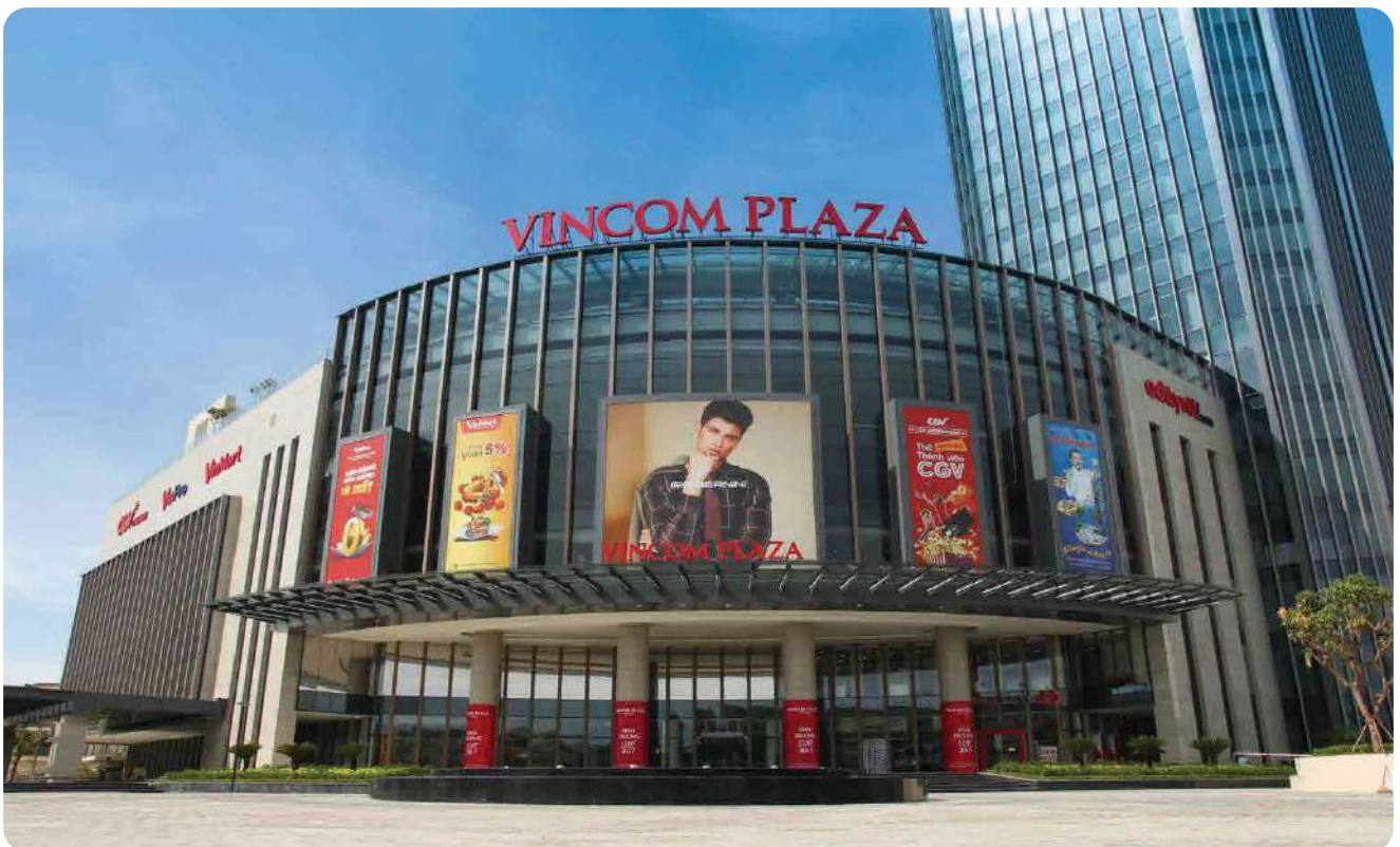
Dự án Vincom Plaza Hà Tĩnh Vincom Plaza Ha Tinh
