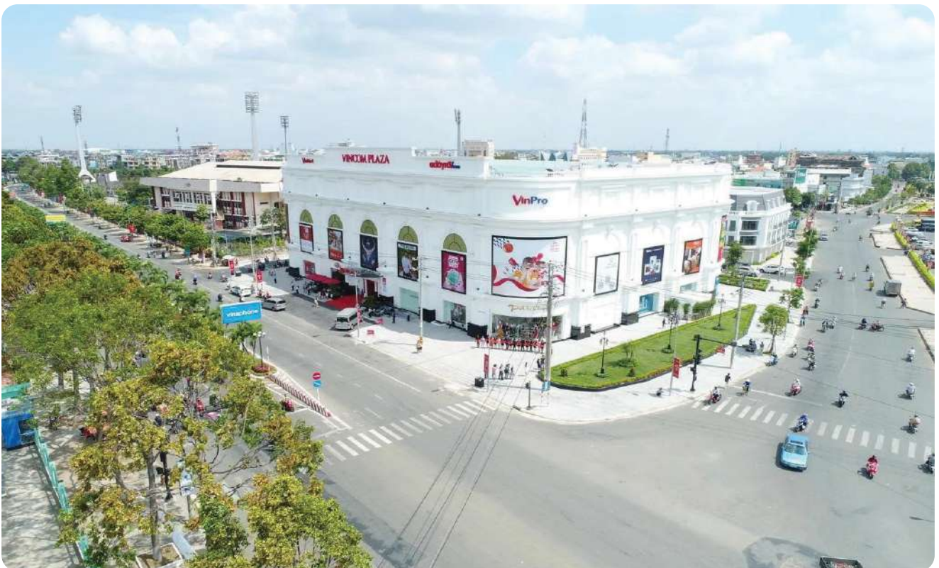
TTTM Vincom Plaza và Shophouse Cà Mau Vincom Plaza and Shophouse Ca Mau
