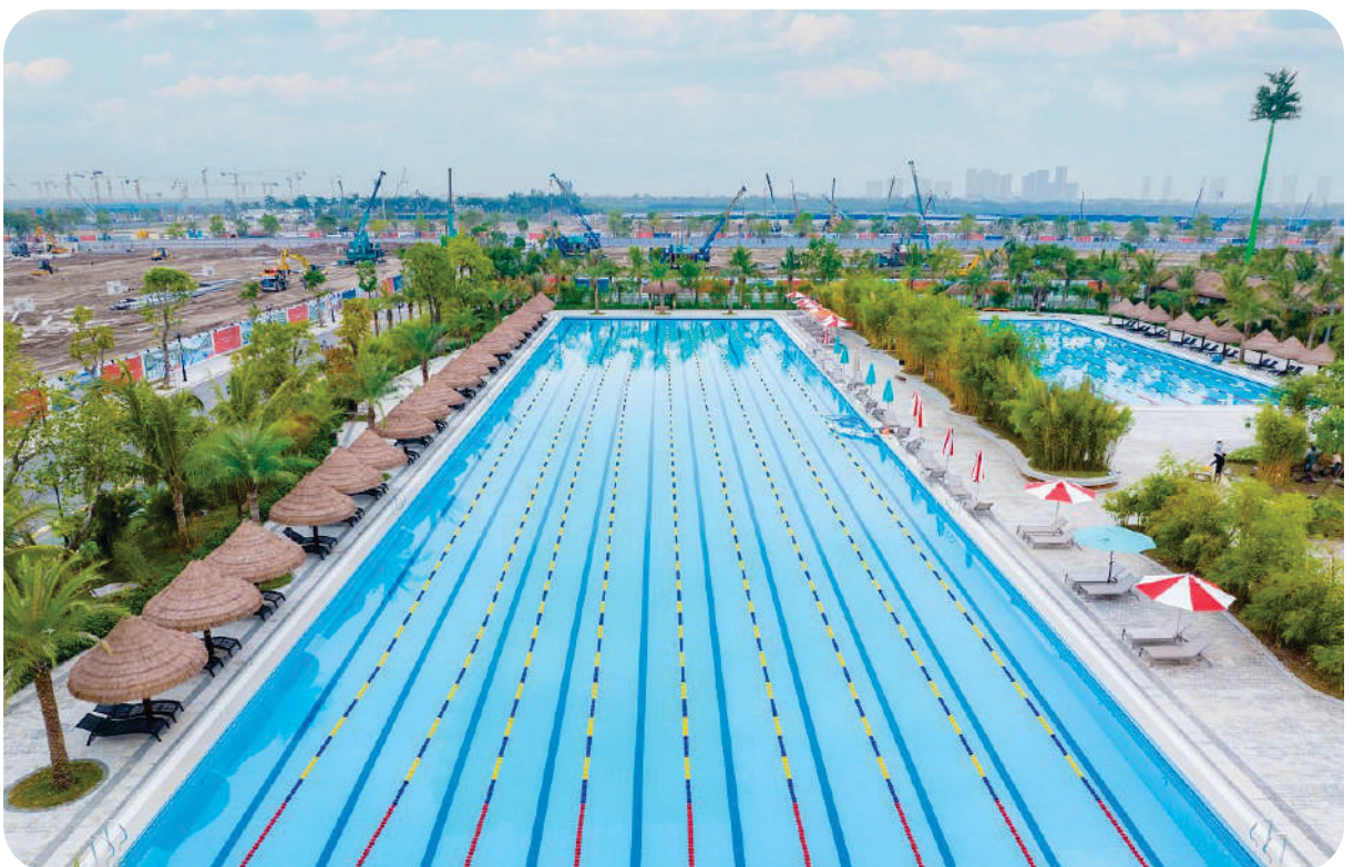
HVC thi công hoàn thiện bể bơi thi đấu tiêu chuẩn Olympic tại Vinhomes Đại An
