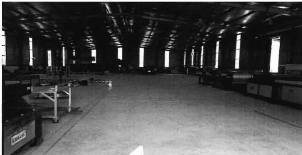
Nhà máy số 1 – HVC Hưng Yên
