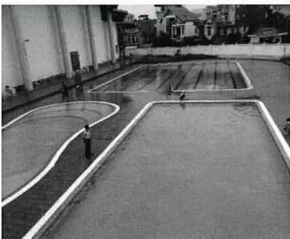
HVC cung cấp lắp đặt thiết bị bể bơi nhà thiếu nhi tỉnh Hải Dương
