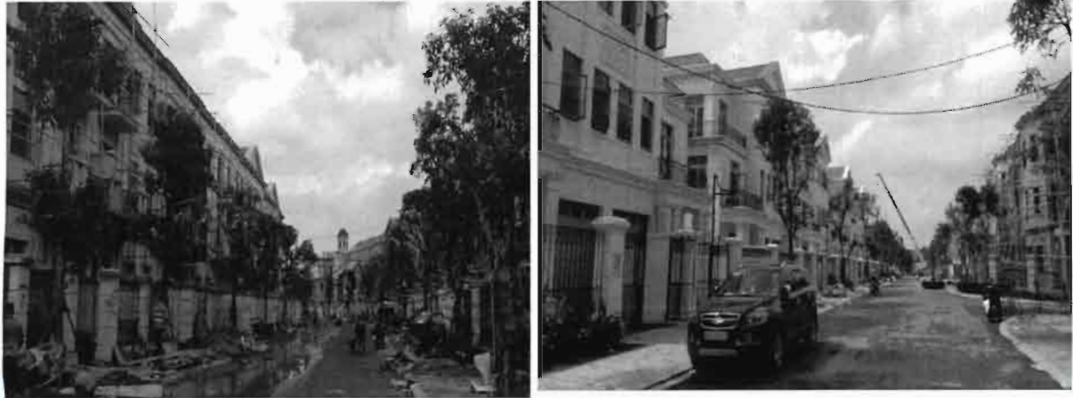
Tổng thầu cơ điện Dự án Vinhomes Riverside 2 – Harmony Long Biên
